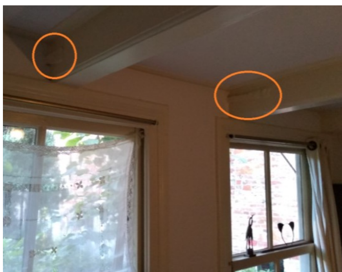
Afbeelding 85: Balklaag bouwdeel drie met oranje omcirkelde gevelankers.
