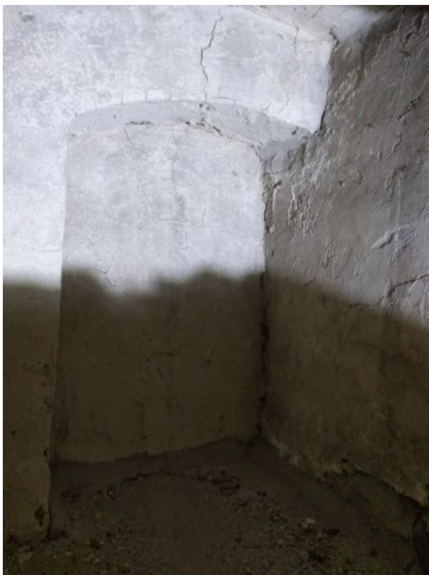
Afbeelding 64: Een getript en dichtgezet venster met een ontlastingsboog van baksteen.
