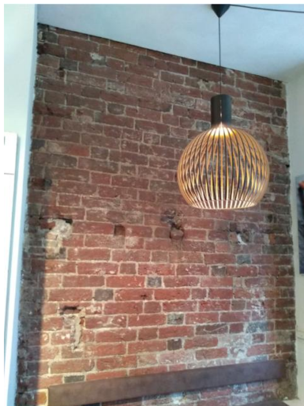
Afbeelding 65: Zichtzijde van de kettingverband muur, dit is te herkennen aan de zorgvuldig geplaatste gesinterde koppen in het gevelvlak.
