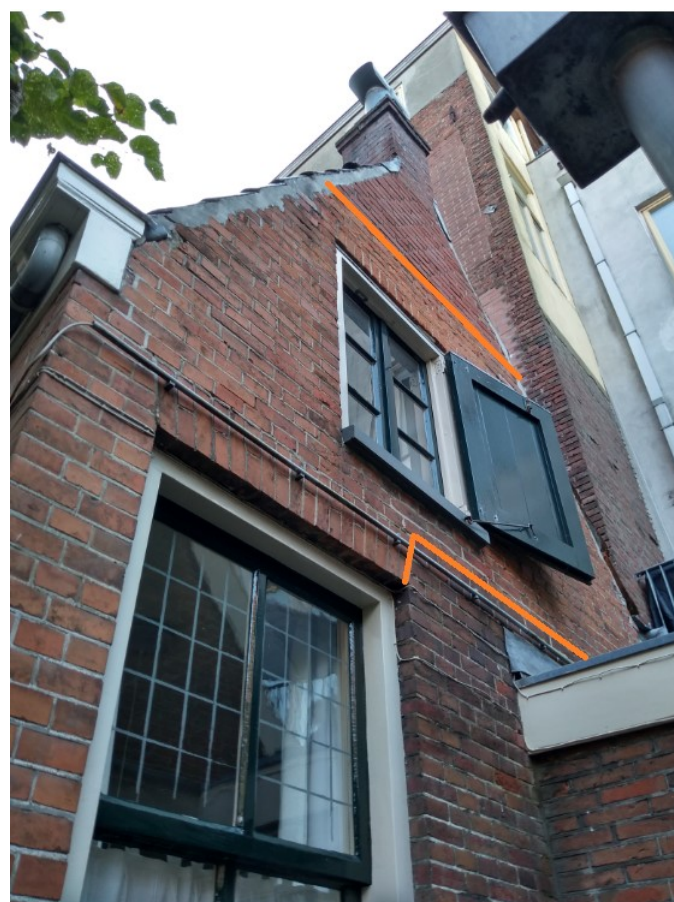
Afbeelding 68: Met oranje scheidslijnen de verschillende metselwerk aangegeven. Het stolpraam is asymmetrisch in de topgevel geplaatst.
