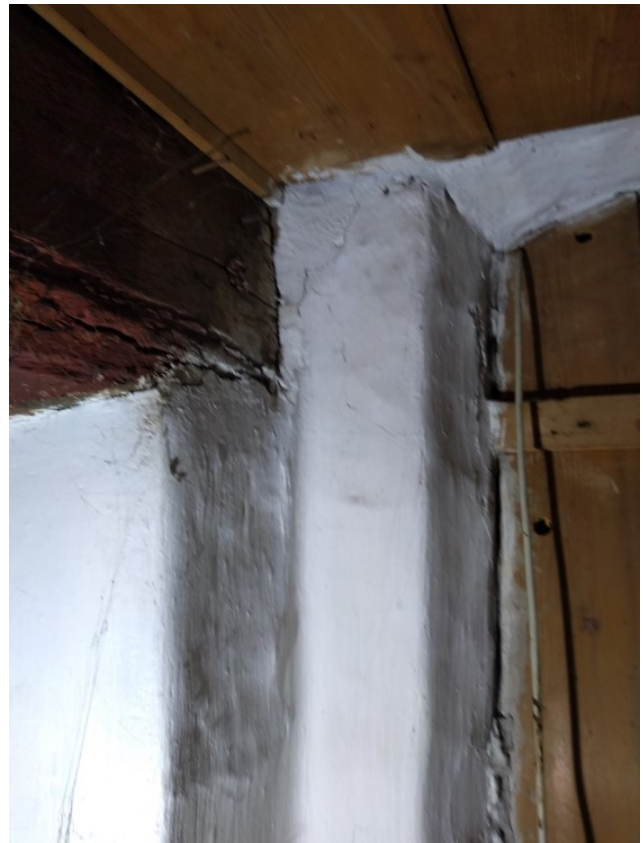
Afbeelding 83: Oplegging bint. De spijkerlijnen van het verlaagde plafond komen overeen met de afstand tussen de ribben.
