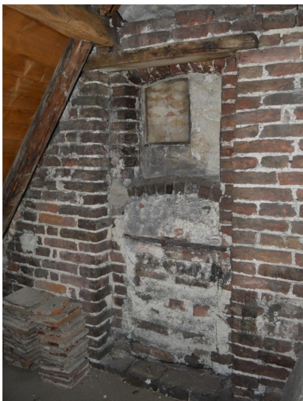
Afbeelding 62: Stenen kloostervenster met een eikenlatei voor het bovenlicht langs. Het kloostervenster had vaak bij de onderste opening een luik. Dit komt zonder borstwering ongelukkig uit en doet vermoeden dat de vloer is verhoogd, foto: J. van der Hoeve.
