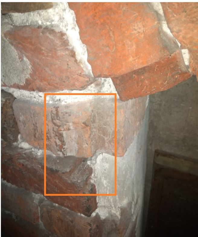
Afbeelding 58: Verscholen venster ten hoogte van de lessenaarsvloer. Omkaderd een bouwspoor van een duimblok. De brede luiksponning is duidelijk zichtbaar.
