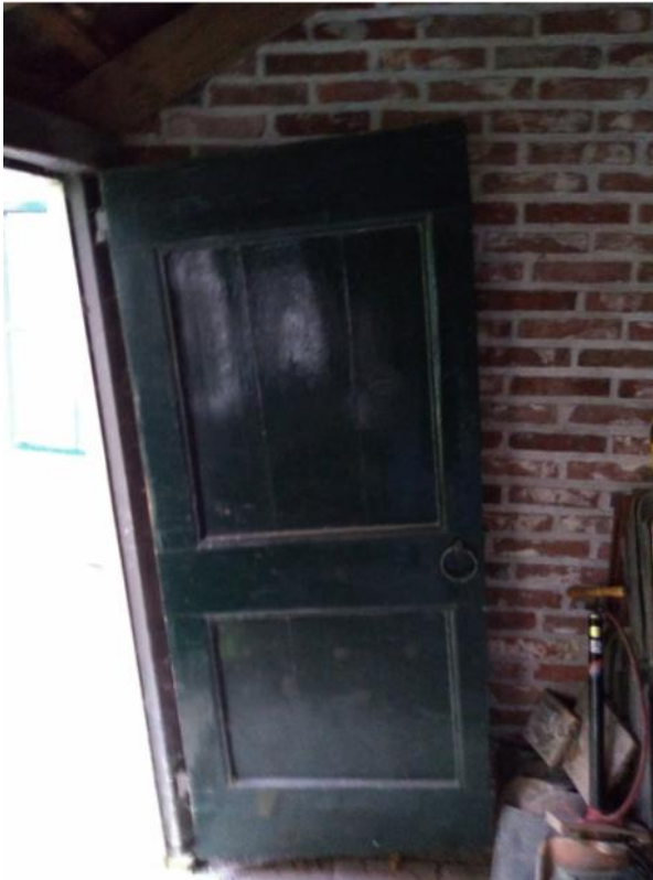
Afbeelding 77: Linkerzijgevel met de ongelijke verdeelde paneeldeur en verticale delen.
