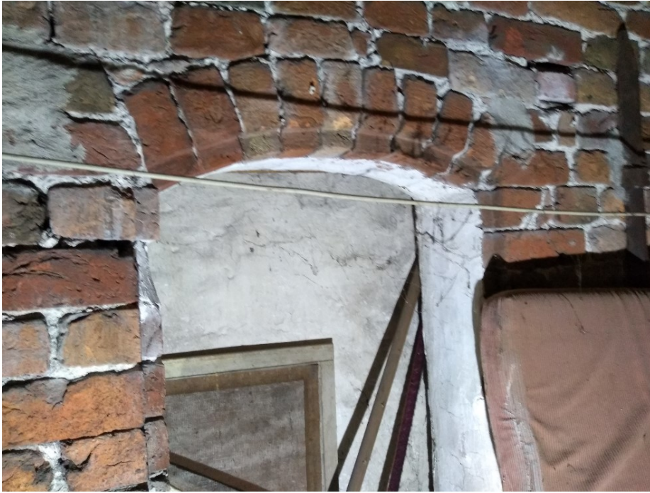
Afbeelding 57: Venster met een gemetselde ontlastingsboog met rechts ernaast een gevelanker.
