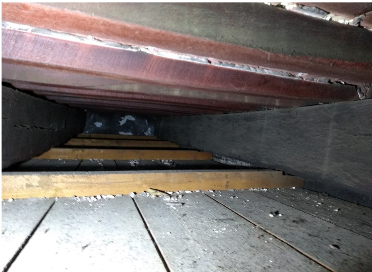
Afbeelding 81: De balklaag met op de ribben zaag aftekeningen zichtbaar. Een aangebracht plafond (ingekeept) onttrekt de vloer uit het zicht.
