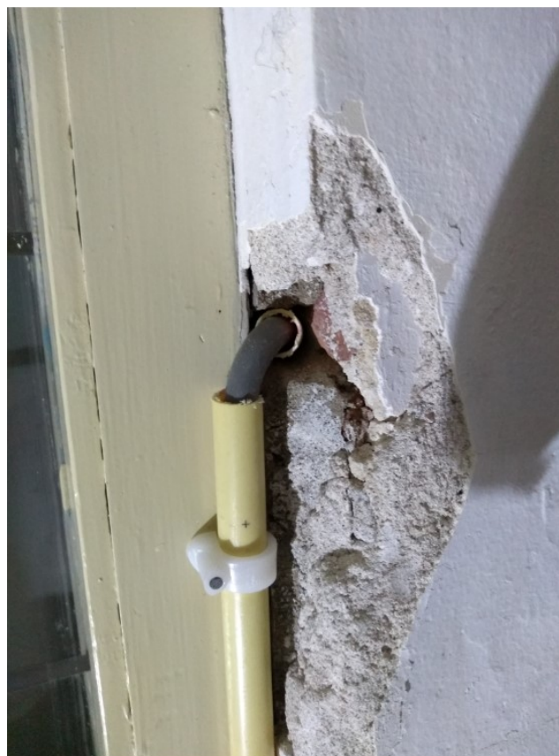
Afbeelding 28: Rondom de centrale hal is rood metselwerk aangetroffen.
