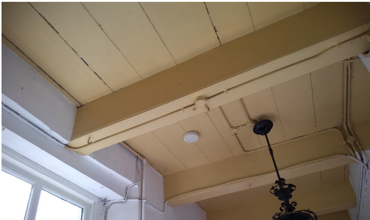
Afbeelding 84: Kraalafwerking en verankering van de enkelvoudige zolder balklaag.
