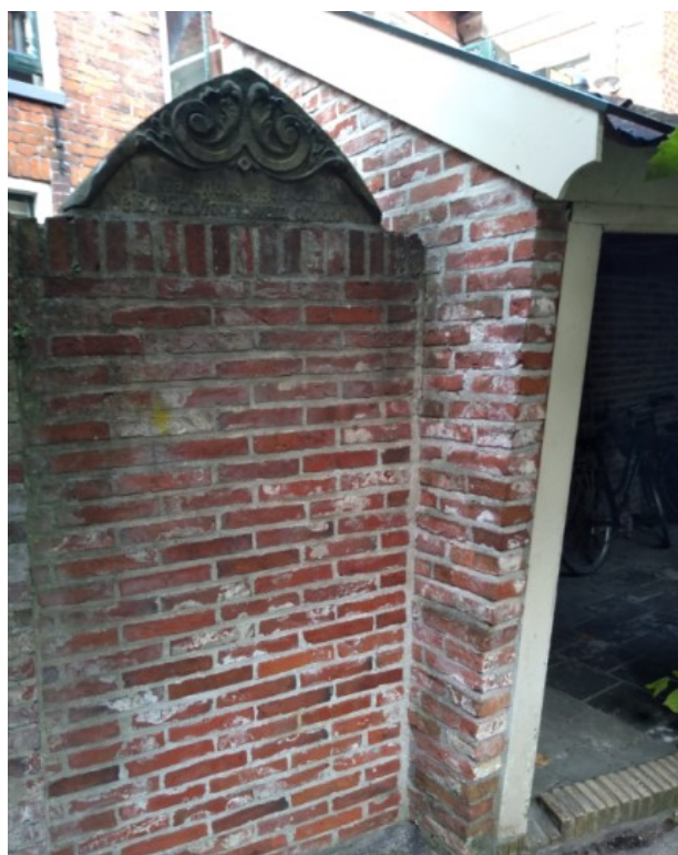
Afbeelding 37: Linkerzijgevel. Een verticale naad en verspringende lintvoegen geven een koude aansluiting aan.
