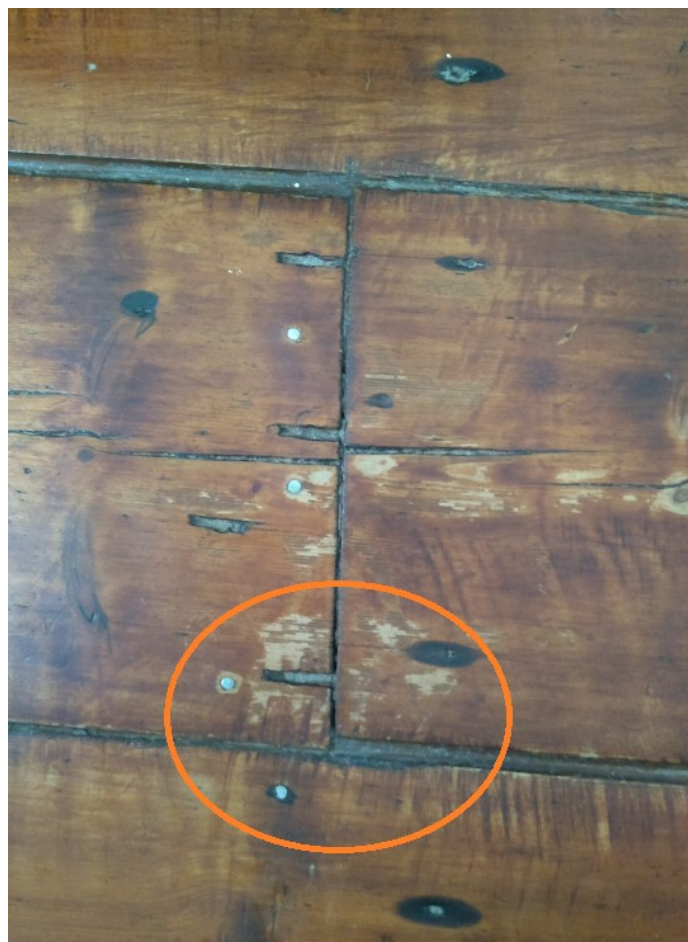
Afbeelding 103: Grenen vloer met oranje omcirkeldeen aansluiten tussen de delen. De veer loopt ter plaatse van de stuiknaad door.
