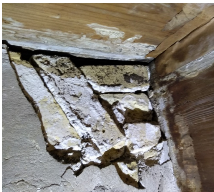
Afbeelding 22: Geeltjes aangevuld tegen de zoldervloer. De binnenwanden zijn na de achttiende eeuw geplaatst. De schoorstenen van de kamers zijn met dezelfde geeltjes gemetseld.
