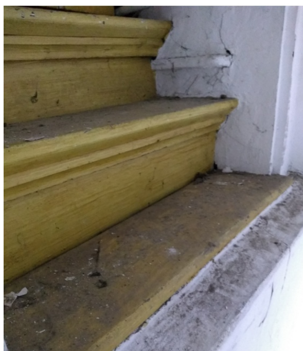
Afbeelding 107: De trap die hoog in de gang bevindt. De wellat profiel komt overeen met die van de zoldertrap.
