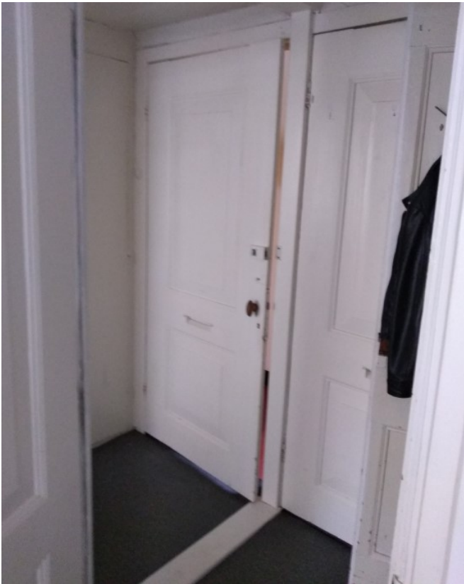
Afbeelding 43: Samenvoeging op de verdieping. Bij de voordeuren van de linker- en de middelste kamer werd een gedeelte van de binnenwand verwijderd.
