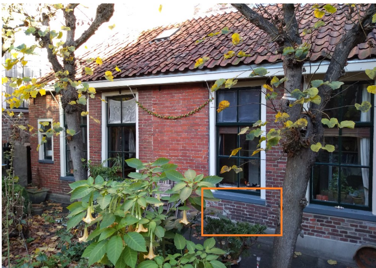
Afbeelding 69: Het linkerdeel (tot en met de derde kozijn) en de zijgevel bestaat uit halfsteens verband. Het overige metselwerk op het oranje omkadering na is in kruisverband gemetseld. In het middenpenant zijn bouwsporen zichtbaar waar de linker- in de rechterzijde is ingeboet. Het linkerdeel kwam tegen het rechtergedeelte aan.
