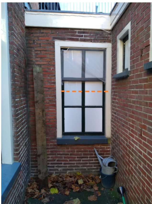
Afbeelding 70: Venster met bouwsporen aan de dagkant van een verhoogde wisseldorpel (oranje stippellijn). De muur met de twee kleine vensters sluiten koud tegen het andere bouwdeel aan.
