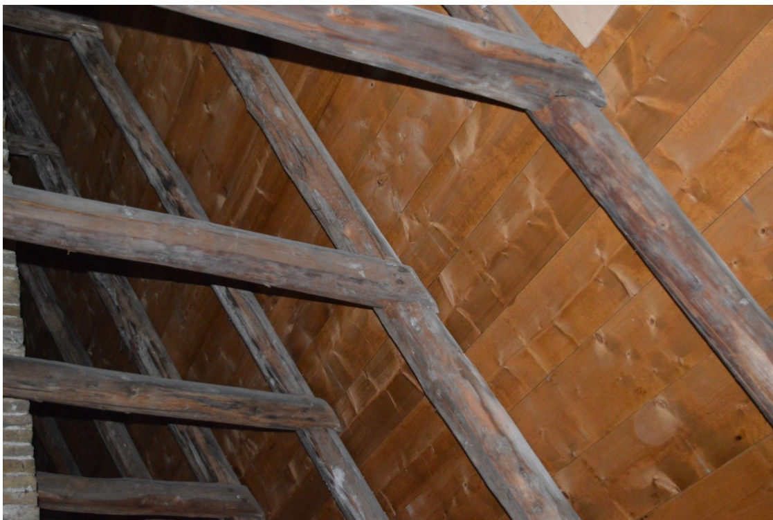
Afbeelding 20: Naaldhouten daksporen zonder telmerken. De sporen zijn halfhouts met de hanenbalken verbonden. Dit zijn dateringkenmerken voor een achttiende-eeuwse kap, foto: J. van der Hoeve.
