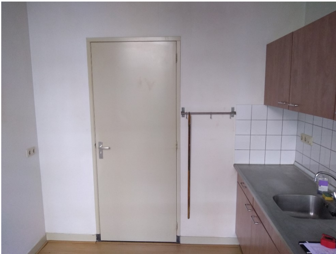
Afbeelding 45: Toegangsdeur naar de bijgebouwde douche.
