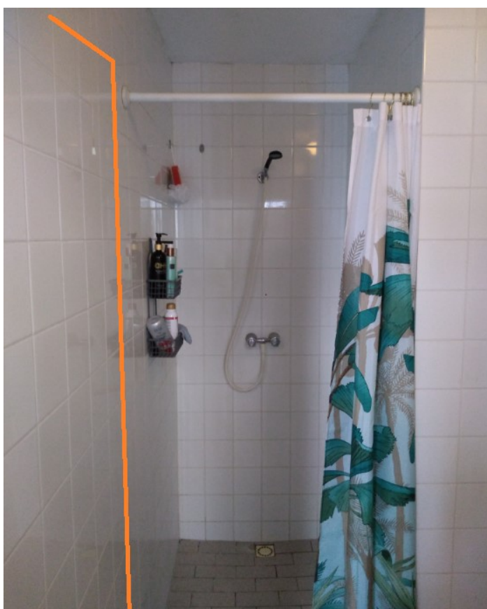
Afbeelding 38: De gemeenschappelijk douche die bij de opsplitsing bij de rechterkamer is toegevoegd. Bij deze verbouwing werd het deurkozijn verplaatst. De oranje lijn geeft de oorspronkelijke entree aan.
