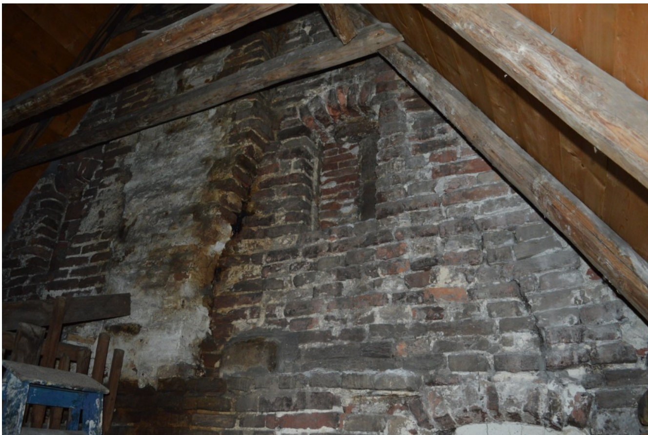
Afbeelding 66: Overzicht foto van de topgevel met de bouwsporen en schoorsteenkanaal. De vensters zijn dichtgezet of kijken uit naar het metselwerk van het buurpand, foto: J. van der Hoeve.
