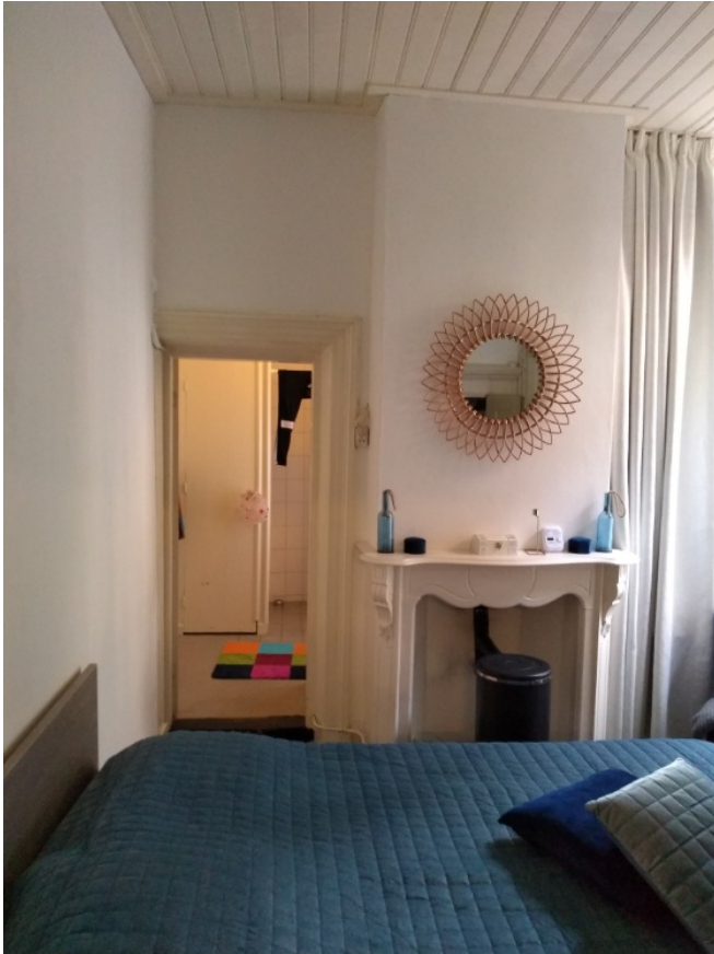
Afbeelding 115: Doorbraak naar bouwdeel vier met aan de linkerkant een wegvallende deurstijl. De schouw heeft met zijn diagonale consoles neorenaissance kenmerken (Zantkuijl, 1973-1992), p. 382-391.
