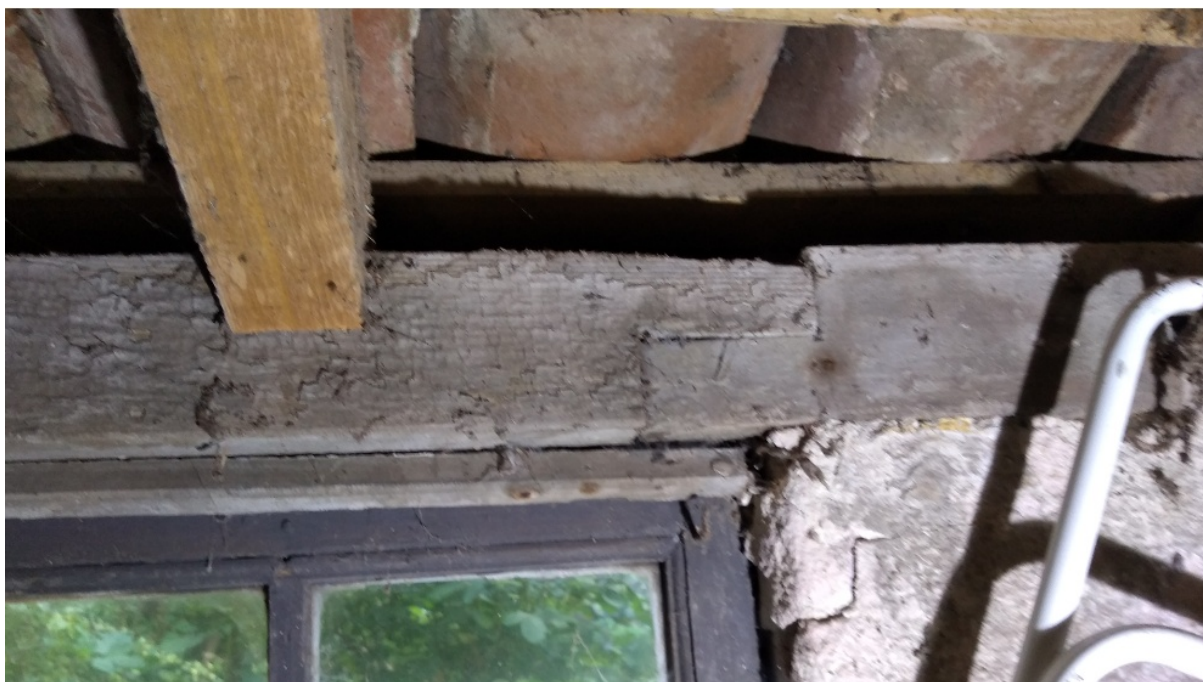
Afbeelding 100: Muurplaat met een gelipte verbinding. De sporen liggen met een visbek inkeping op de muurplaat.
