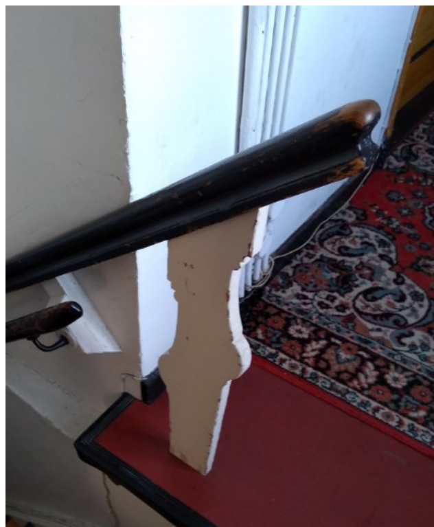
Afbeelding 18: Een verdwaalde balustrade met de achttiende-eeuwse hol/ bol profilering. De bovenste treden komen ongelukkig uit met het verdiepniveau.
